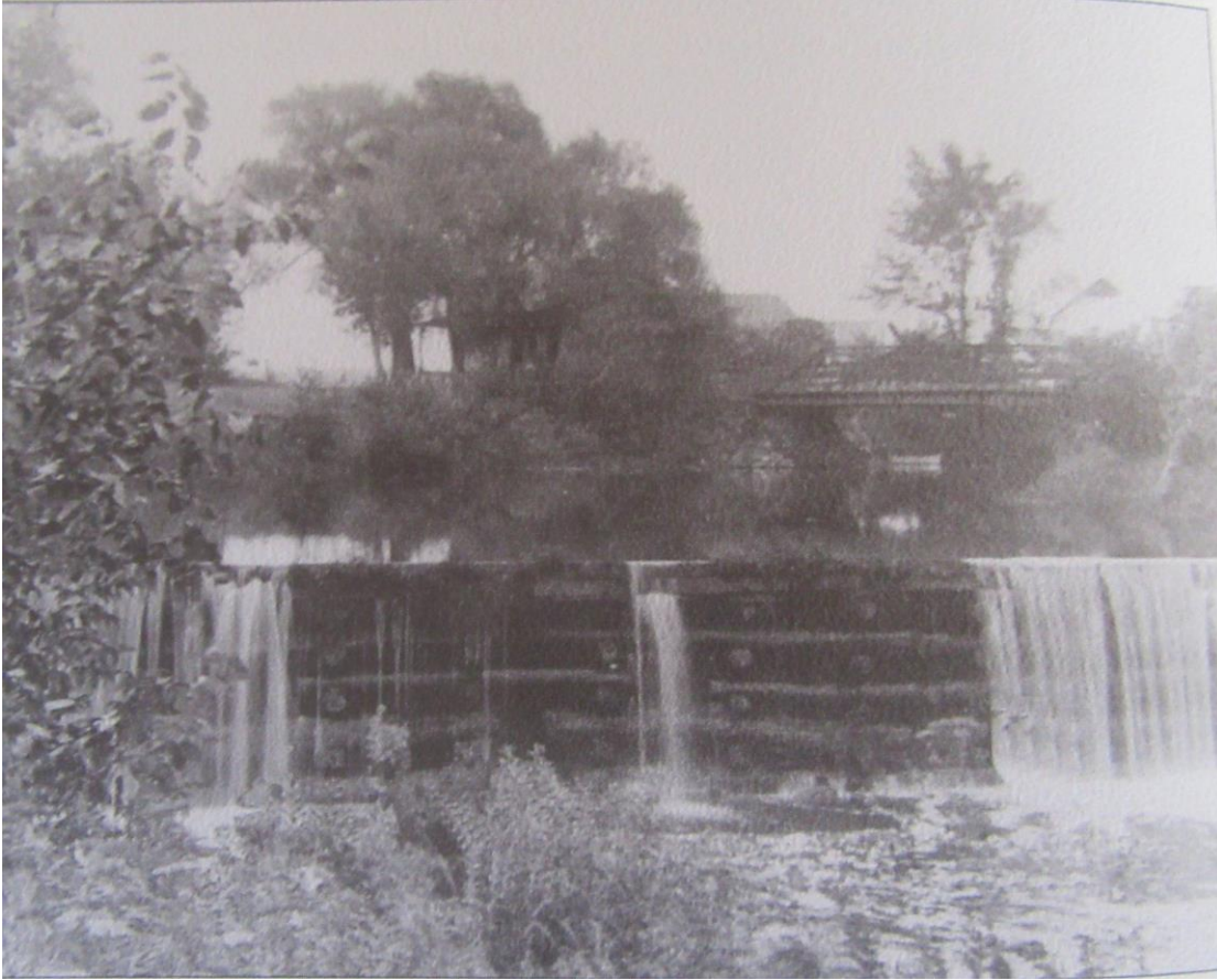
Photo vers 1890 du pont de fer du 3 e Rang Ouest à l'arrière. Il n'y avait pas les deux piliers actuels dans le lit de la rivière, mais un amoncellement de roches de chaque côté pour supporter le tablier du pont, ce qui réduisait beaucoup la largeur de la rivière à cet endroit et devait provoquer des embâcles. (album 150 e )
