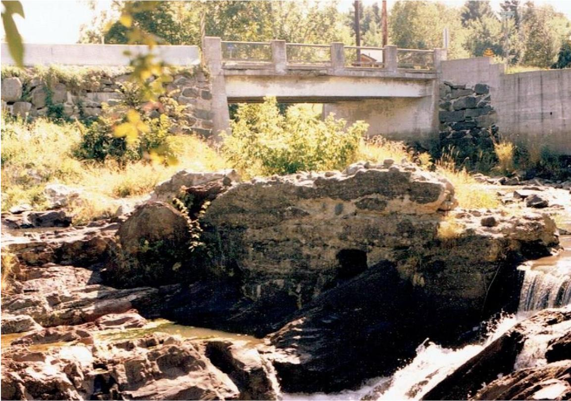
Photo de 1984 de l'emplacement du barrage Hungerford, qui avait une hauteur de 18 à 20 pieds et retenait l'eau à la hauteur du tablier du pont sur la 137 et la refoulait jusqu'au pied du barrage Lacasse, aussi construit par les Hungerford. Au centre, dans le bas du barrage, subsiste la trappe pour évacuer l'eau et vider ainsi le réservoir.
