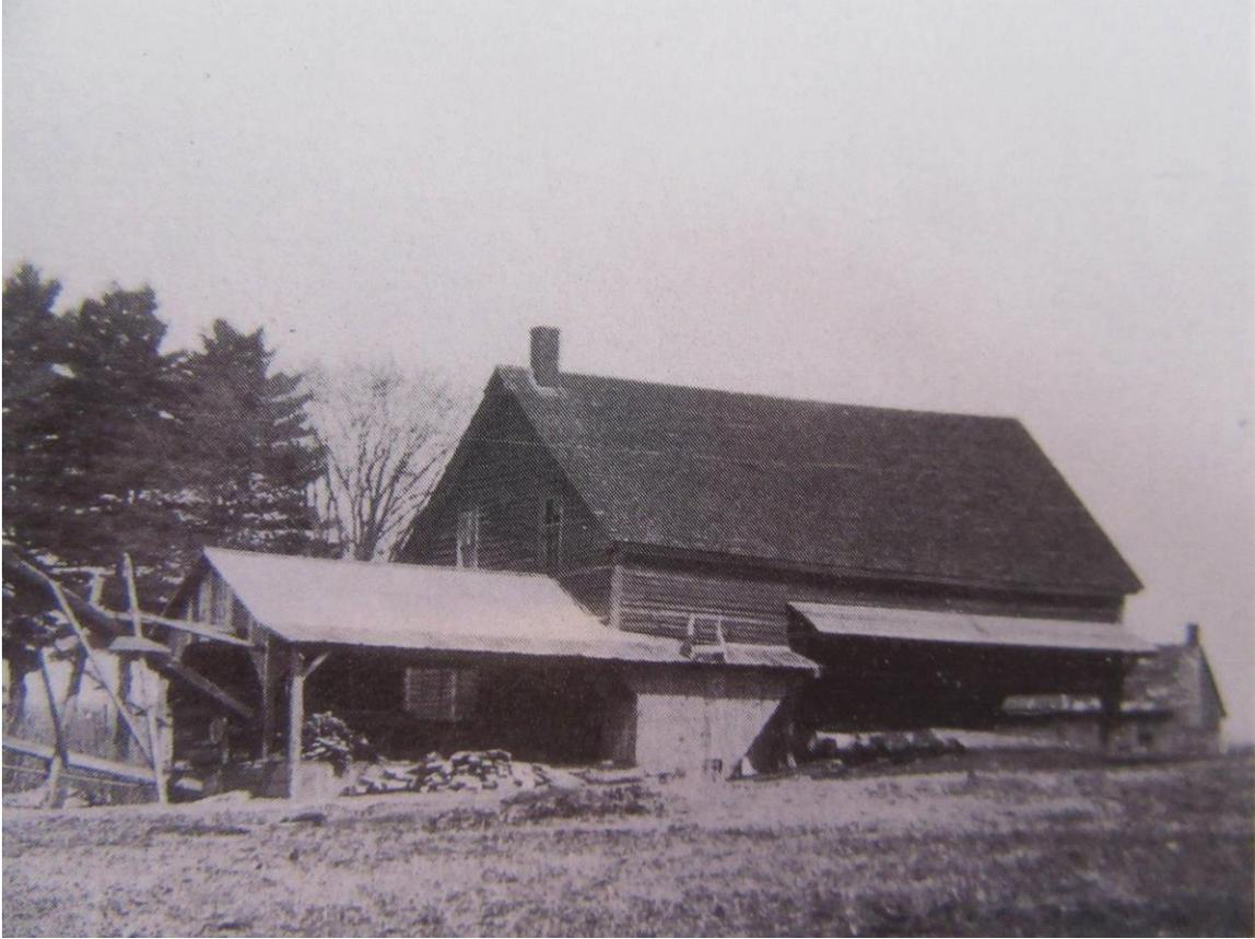
**Moulins Gousy vers 1930. Le moulin à farine était à l'arrière et celui à bois à l'avant. On pouvait y scier des billots jusqu'à 45-50 pieds en les laissant dépasser du chariot qui roulait sur des rails. Les murs étaient faits de madriers de deux pouces d'épaisseur. La bâtisse était celle construite jadis par les Hungerford. (Coll. Sylva Gousy) (Histoire du Canton de Granby)**
