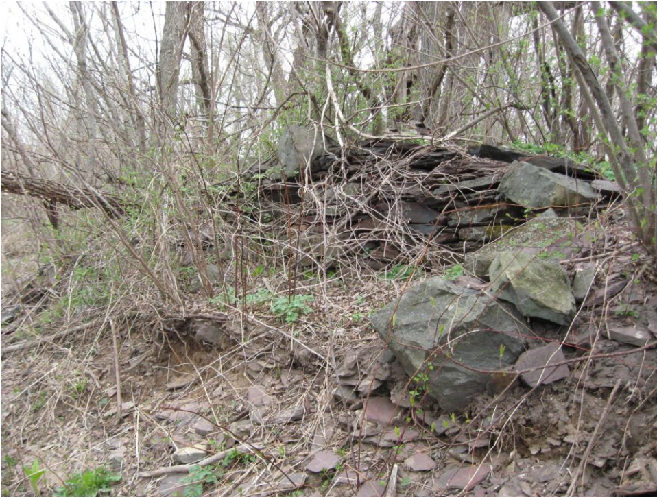
Tannerie : mur d'un support de la roue d'eau ou d'une 3 e bâtisse
