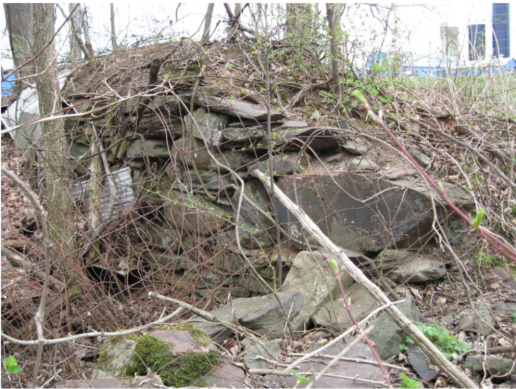
Vestiges de la tannerie, première bâtisse : les cuves?
