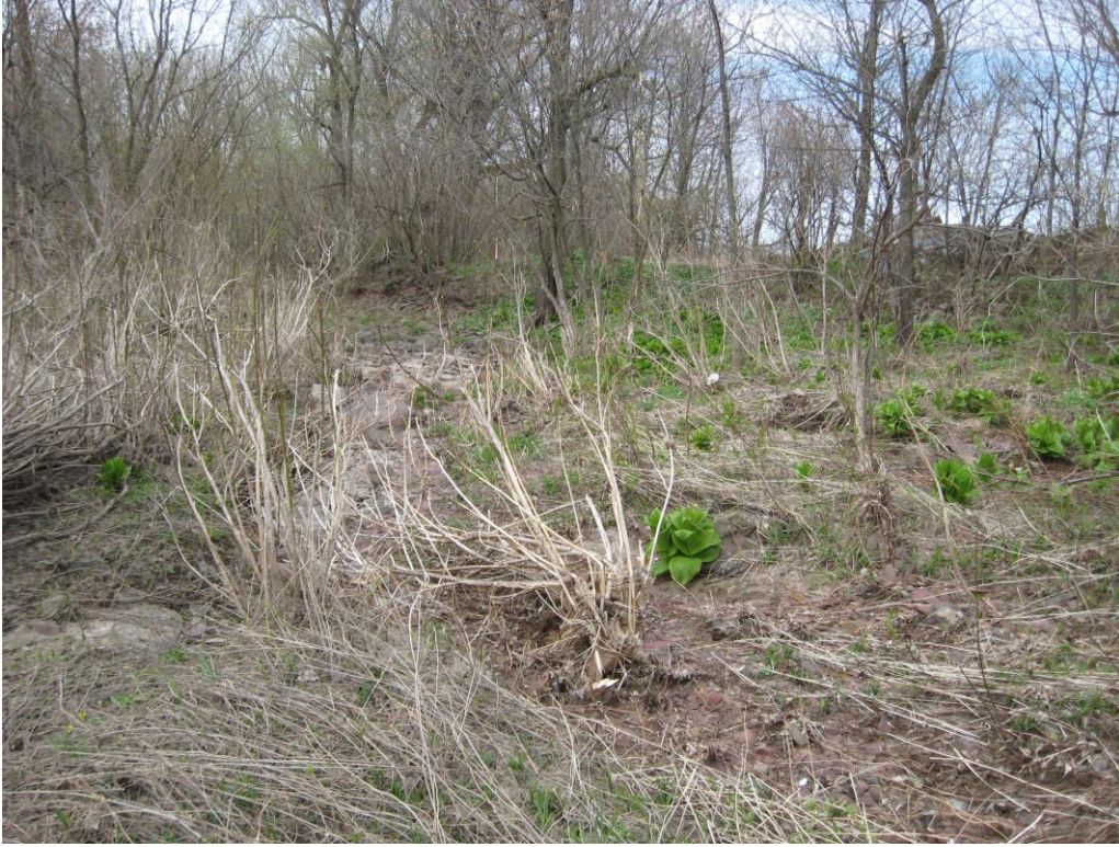
Canal de dérivation, vue vers l'aval
