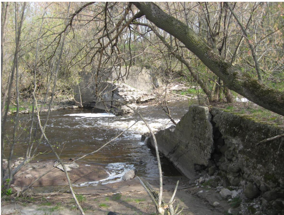
Barrage Cook : avant-plan, partie sud; arrière, partie nord
